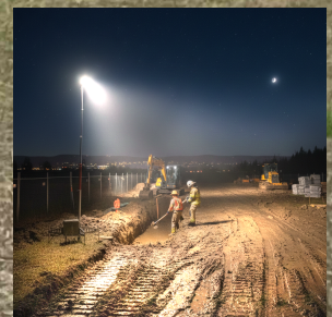
工事現場・建設現場
